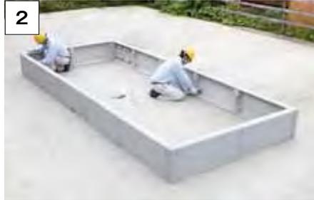
2 パネル連結部のボルトを仮締めします。(A-1) ※補強ベース(E)を使用する場合は、この段階でアームを取り付けてください。
