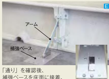
「通り」を確認後、補強ベースを床面に接着。
