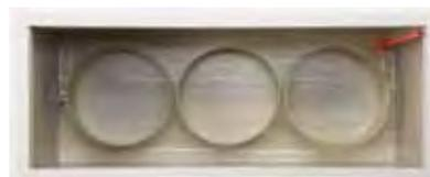
仕切板を設置後、給水布を差し込み給水管を設置します。
