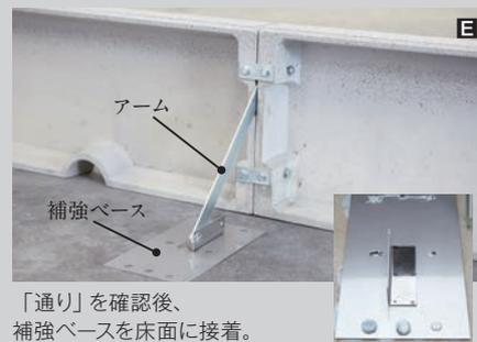
「通り」を確認後、補強ベースを床面に接着。
