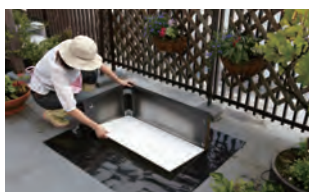
ダンプレートを設置します。
