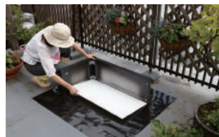
ダンプレートを設置します。
