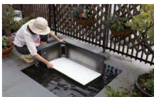
ダンプレートを設置します。
