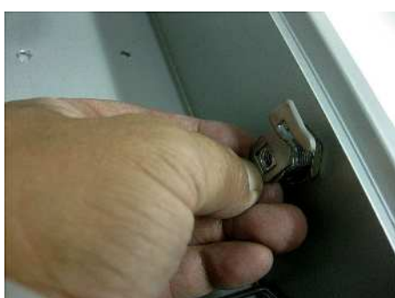
引っかかり金物をワッシャー・ビスで締付けてください
