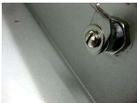
引っかかり金物をワッシャー・ビスで締付けてください
