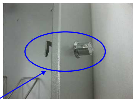
締付けた状態 シリンダーが縦で引っかかり金物も縦・横で横になり引っかかる状態です。
